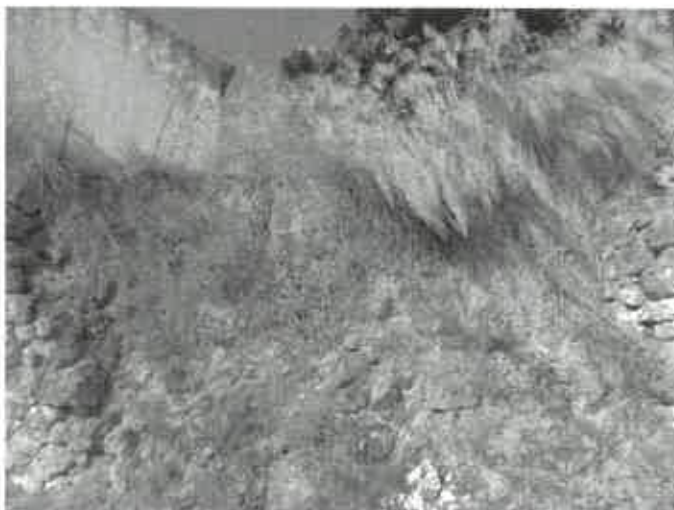
Muro de contenção de terras em alvenaria de pedra solta
