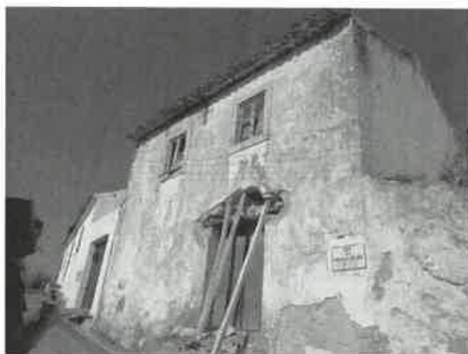
Fachada principal do edifício objeto da vistoria
